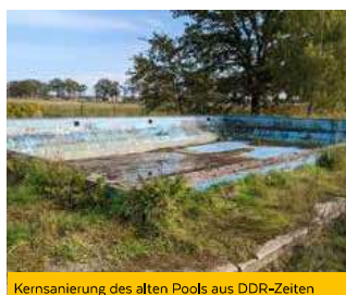
Kernsanierung des alten Pools aus DDR-Zeiten
